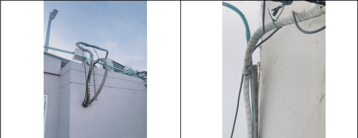
8. Reorganizacion de cableado exterior, tubos de desagues de aires acondicionado bajantes de aguas lluvias
