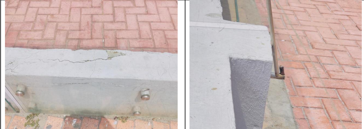
20. Mantenimiento herrajes de vidrios perimetrales inferior
