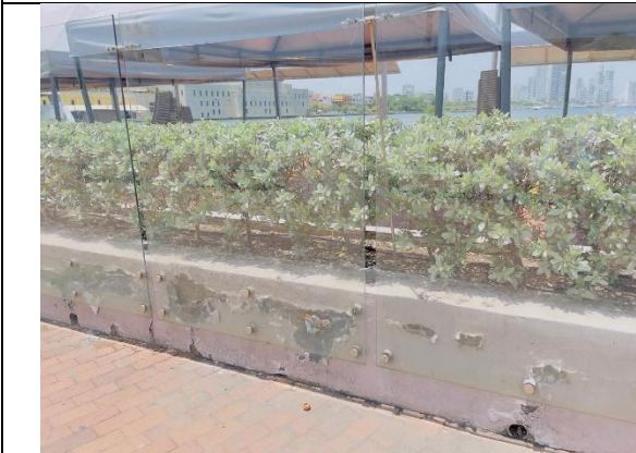
18. Mantenimiento muro soporte vidrios perimetrales
