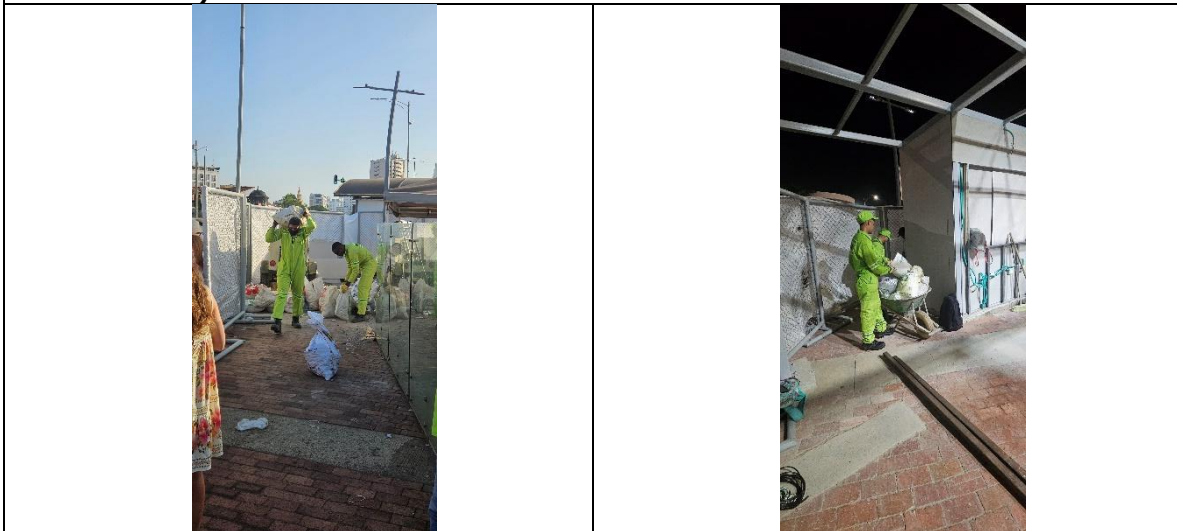
2. Limpieza final de obra y retiro de material sobrante
