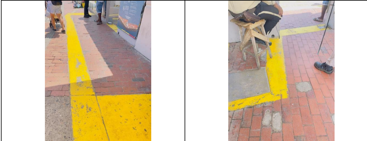
5. Demarcación línea entrada puerta 2 (ancho 15 cm)
