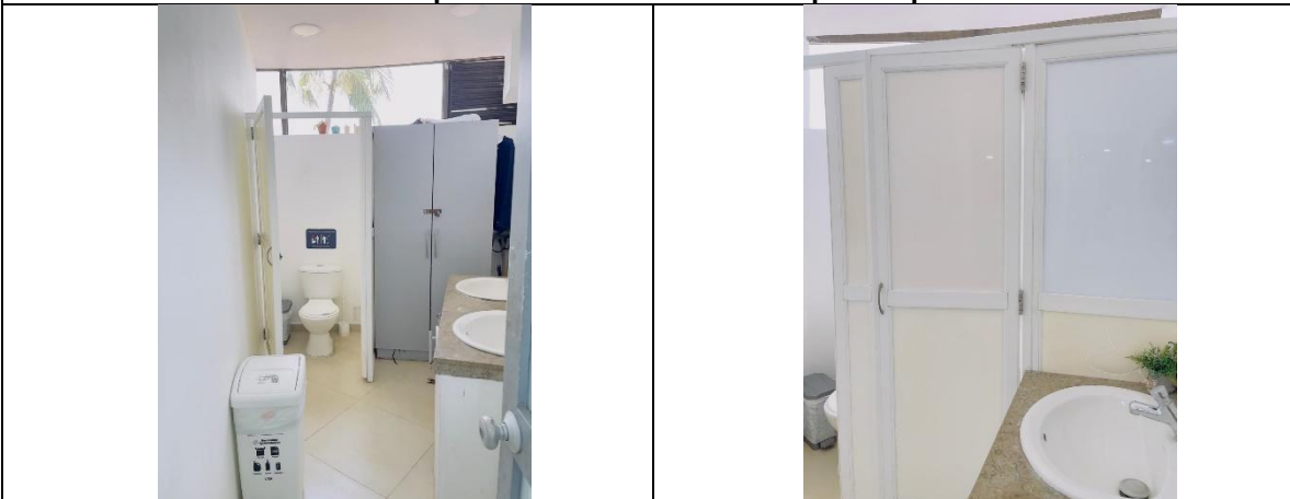
12. Suministro e instalación de divisiones de baños mujeres y hombres primer piso incluyepuertas, bisagras, tornillos y montaje donde se requiera
