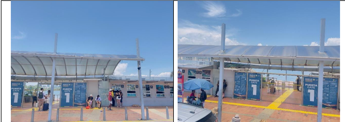
Reestructuración de puerta 1 proyectando mantenimiento y remplazo de piezas dañadas incluye tensores, vidrios y láminas de policarbonato
